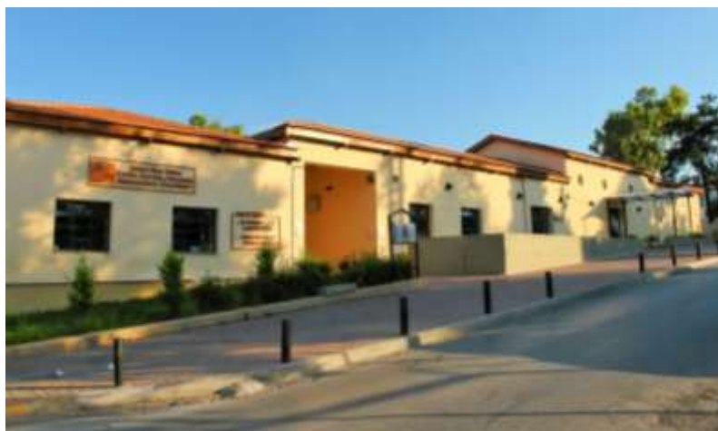
Τα κτίρια της οδού Πατρ. Ιωακείμ που αποκαταστάθηκαν
