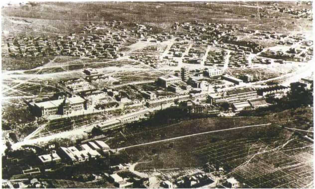
Γενική άποψη των εργοστασίων στον Περισσό (φωτογραφία του 1929)
