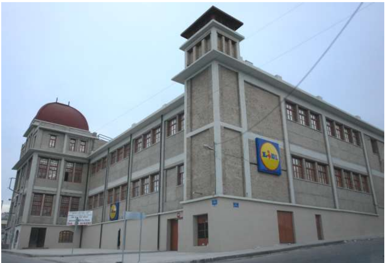
Το διατηρητέο κτίριο της Βαμβακουργίας στεγάζει σήμερα σούπερ μάρκετ... Η διατήρηση της ιστορικής μνήμης θυσιάστηκε στο βωμό του κέρδους.
