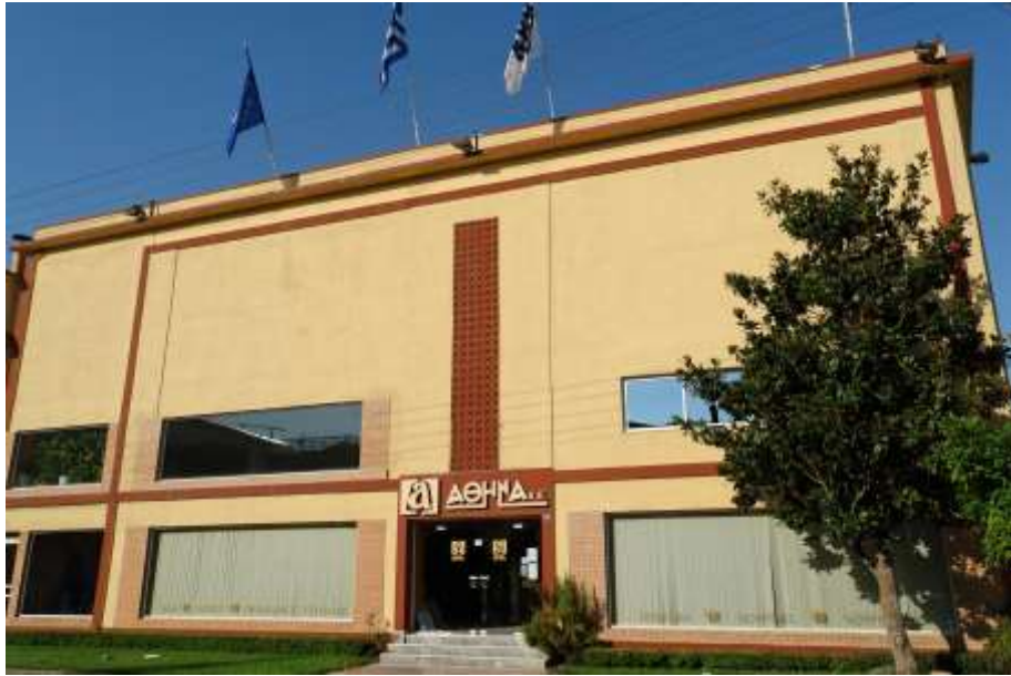
Άποψη του εργοστασίου ΑΘΗΝΑ από την οδό Φιλικής Εταιρείας
