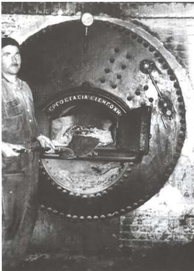
Ο θερμοστής ελαιτριβείου στη Μυτιλήνη φωτογραφίζεται μπροστά σε ατμολέβητα κατασκευής του εργοστασίου Ισηγόνη της Σμύρνης
